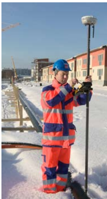
Inmätning av VA-ledningar
